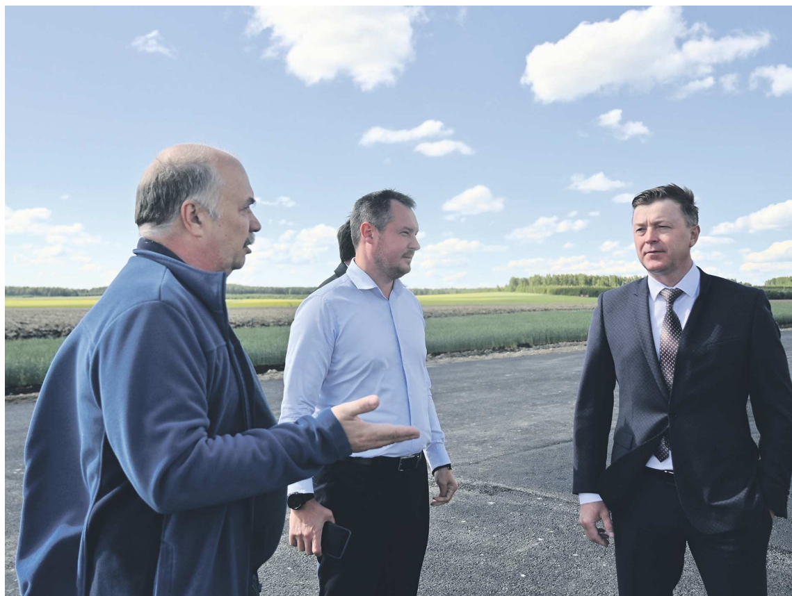
Представитель подрядчика Эдуард Черемных уверил Дмитрия Нисковских (в центре) и Василия Старкова (справа), что все технологии при строительстве соблюдены
