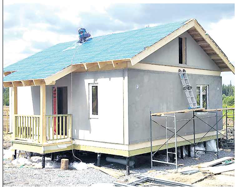
Все дома будут возведены до конца строительного сезона
