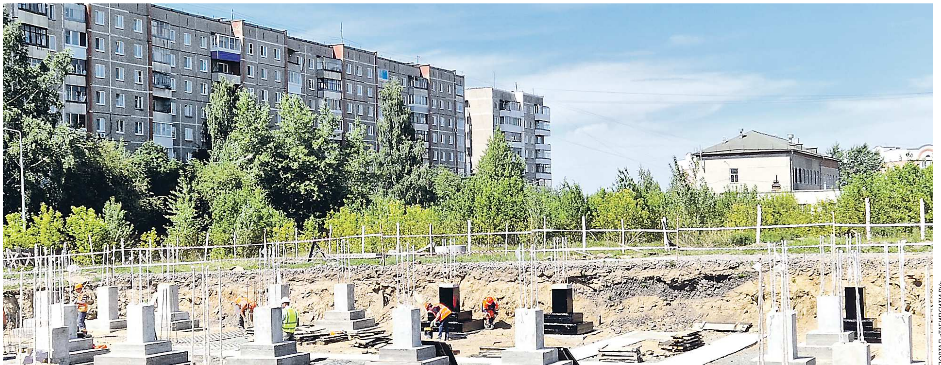
Закладка фундамента под новый культурно-образовательный центр на Гальянке
