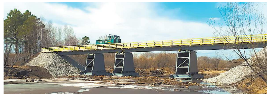
Опоры у моста заменили на металлические, вокруг обустроили территорию для пешеходов
