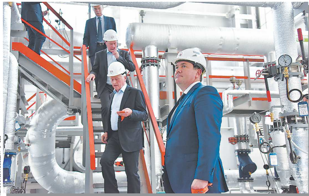
Первый заместитель губернатора Алексей Шмыков и генеральный директор «Т Плюс» Андрей Вагнер осматривают новый высокотехнологичный комплекс теплоснабжения, на 90% укомплектованный российским оборудованием
