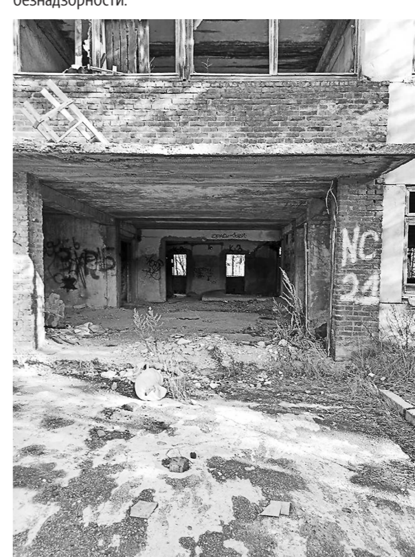
Фото 3. Зброшенний цех, г. Краснотурьинск, ул. Фрунзе, 92
