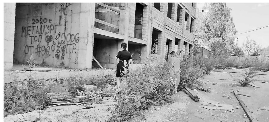
Фото 7. Проверка заброшенного здания
