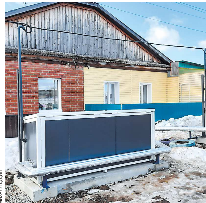
Выносные приборы учета тепловой энергии ставят пока только в одном районе Артемовского, но власти не исключают, что их будет больше
