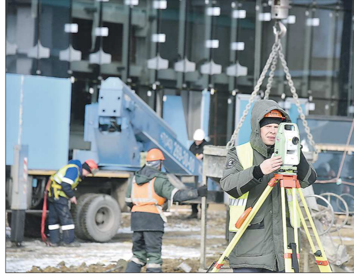
Идёт монтаж фасада Дворца водных видов спорта
