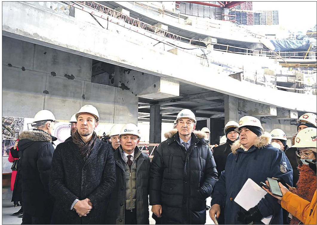
Владислав Третьяк (в центре) вместе с другими делегатами на осмотре строящейся УГМК-Арены
