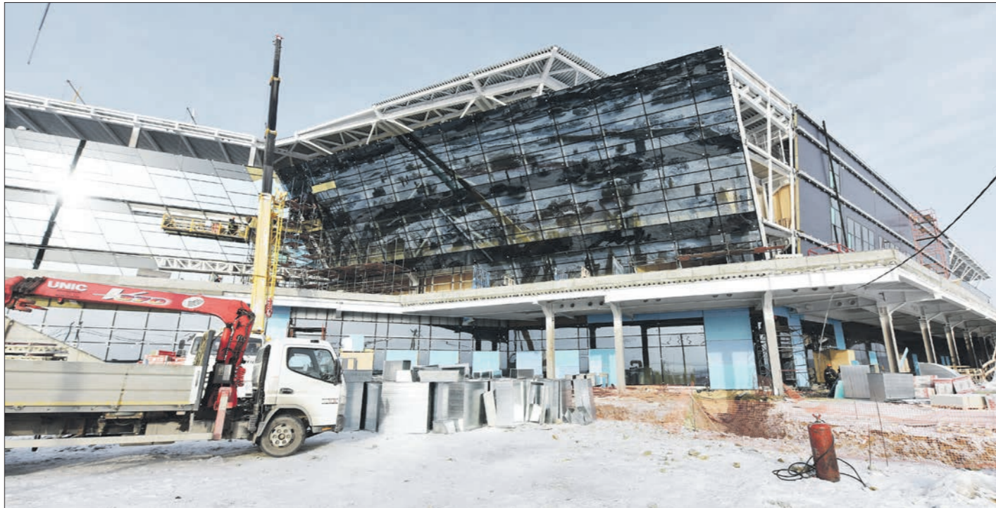
Так на данный момент выглядит Дворец водных видов спорта. Монтаж панелей по правой стороне завершён, а по левой выполнен на 98 процентов
