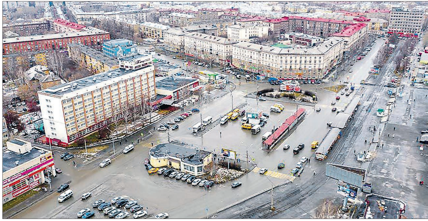
Привокзальная площадь до реконструкции...
