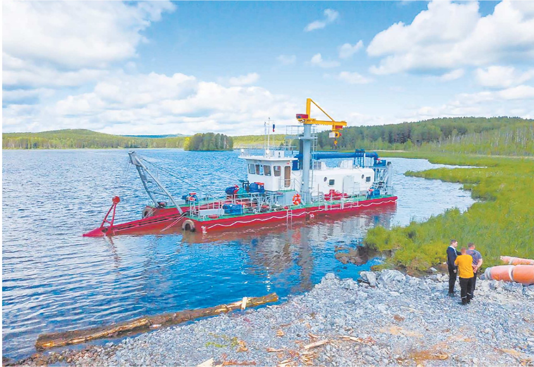
Убирать иловые отложения со дна водоема необходимо, иначе он обмелеет, погибнет рыба, ряска и водоросли будут его заболачивать. Земснаряд эту проблему исключает
