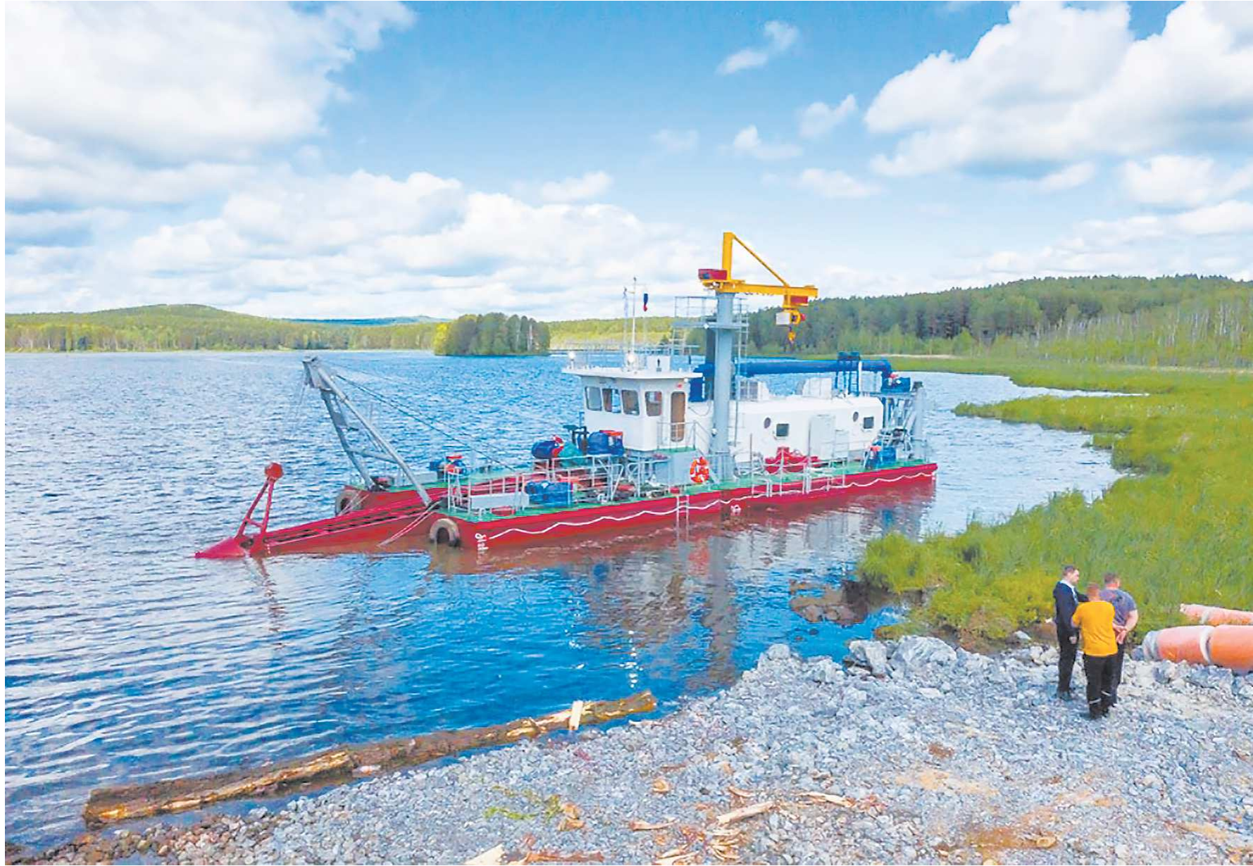
Убирать иловые отложения со дна водоема необходимо, иначе он обмелеет, погибнет рыба, ряска и водоросли будут его заболочивать. Земснаряд эту проблему исключает
