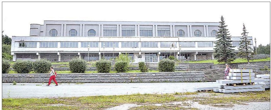
Реконструкция бассейна должна быть завершена к весне 2023 года
