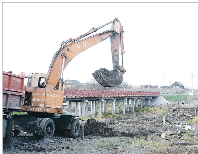
Вот так выглядит новый мост в деревне Молоково. Старую конструкцию на днях разобрали
