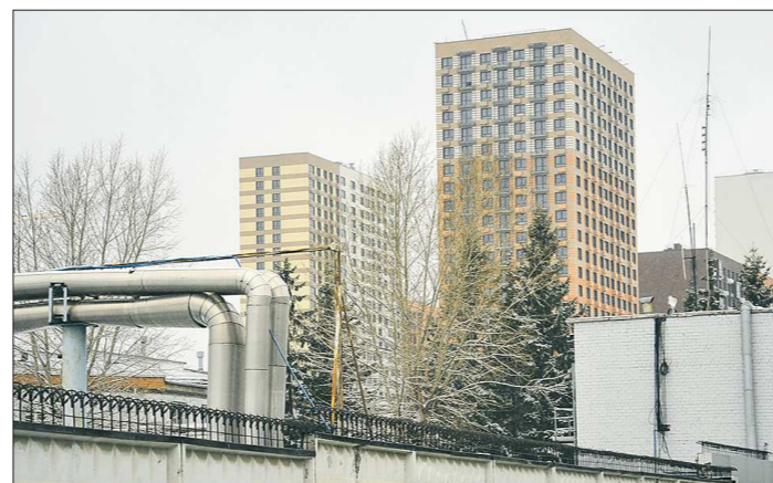
В Екатеринбурге на месте завода «Уралпластик» компания ПИК сейчас возводит несколько жилых высоток. Как заверили «ОГ», перед выходом на площадку была проведена рекультивация почвы и замещение грунта, получено положительное заключение экспертизы. Поэтому проживать в таких домах, по мнению застройщика, безопасно
