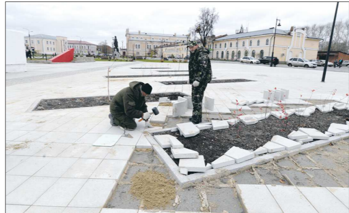
Подрядчики завершают укладку плитки на площади Ленина
