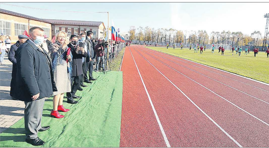
Реконструкция стадиона в Реже стала возможной благодаря сотрудничеству губернатора и правительства Свердловской области с «УГМК-холдингом»
