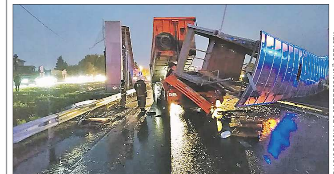
Разрушенный надземный переход сейчас закрыт для пешеходов
