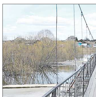
Во время половодья главным способом связи между частями посёлка и соседними деревнями становится подвесной мост
