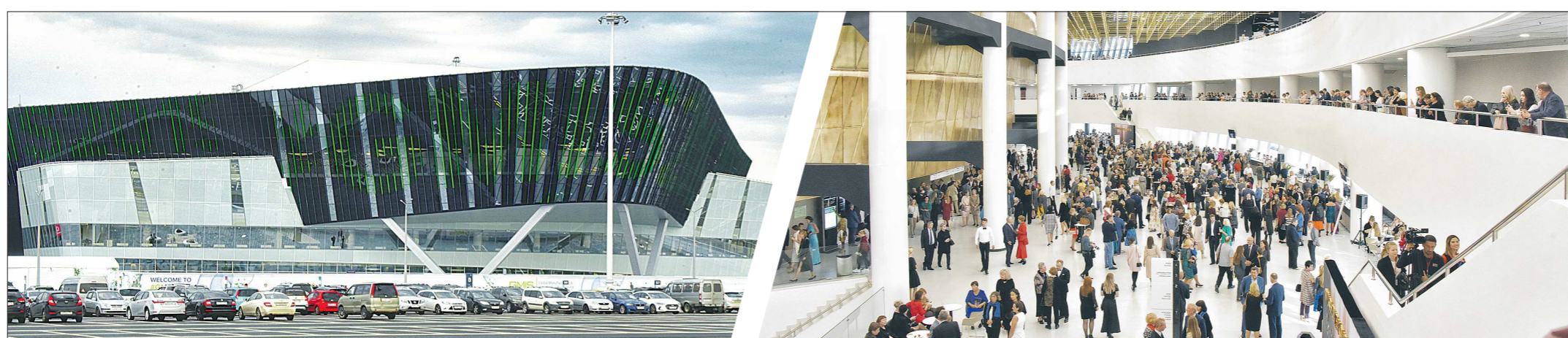
Построенный в 2019 году Конгресс-центр призван расширить возможности МВЦ «Екатеринбург-ЭКСПО». Многофункциональный трансформируемый зал позволяет проводить масштабные общественные мероприятия в различных форматах. Общая площадь Конгресс-центра 41 600 кв.м. Помимо главного зала-трансформера, в центре находится более 40 конференц-залов со SMART-управлением. Сейчас область работает над тем, чтобы максимально использовать возможности Конгресс-центра
