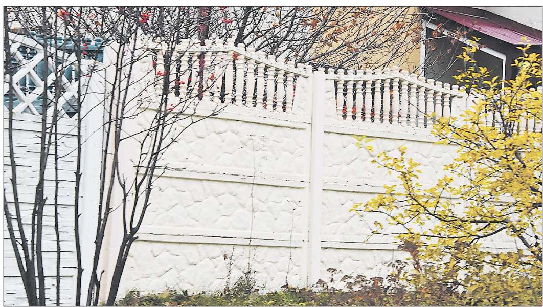
Бетонный забор из самостоятельно залитых панелей выглядит довольно эффектно
