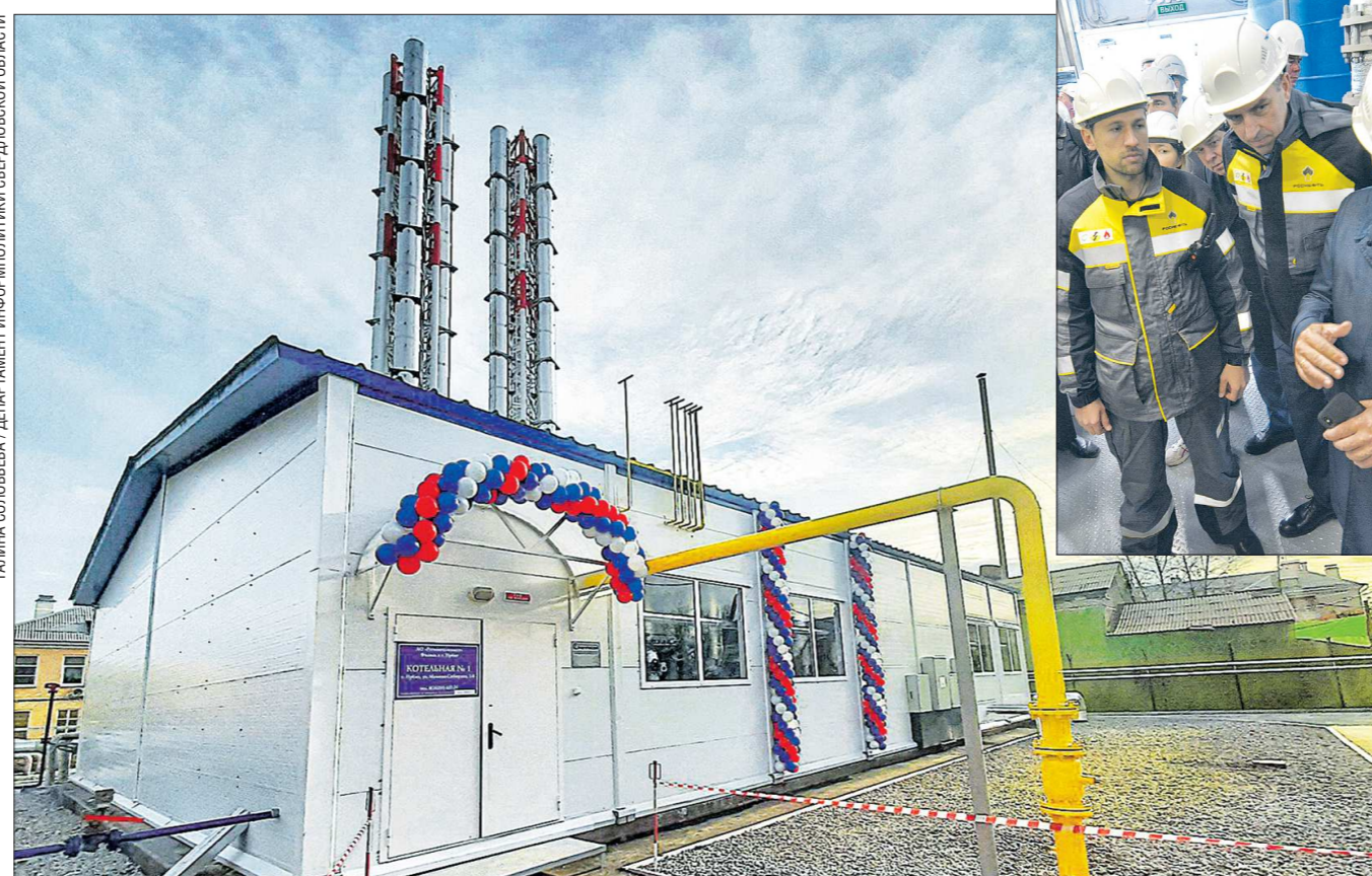
Оборудование новой котельной позволит снизить объём вредных выбросов и теплопотери, а значит - сдержит рост тарифов на отопление в Ирбите
