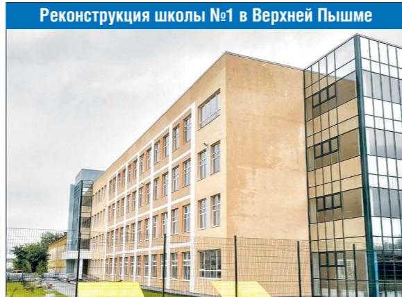
Реконструкция школы №1 в Верхней Пышме Адрес: ул. Красноармейская, 6 Количество учащихся: 1-я очередь – 700, 2-я очередь – 500 Площадь: 17 164 квадратных метра
