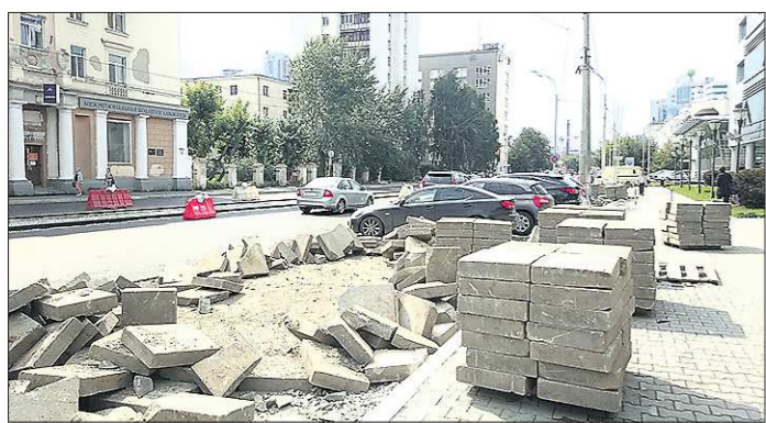
На улице Куйбышева стройматериалы рабочие сложили на тротуаре
