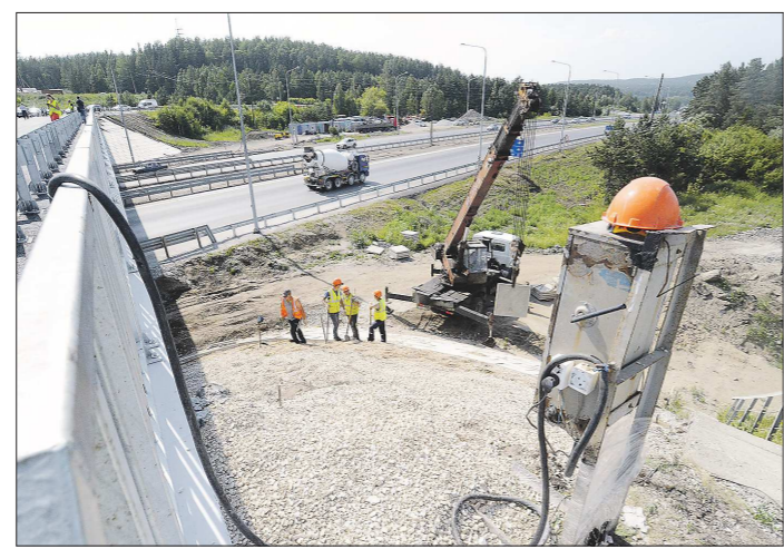
Партии проверили работы на нескольких объектах, в том числе на региональной автодороге Семь Ключей - Большой Исток
