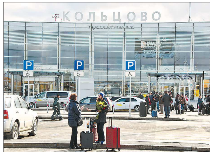
До окончания строительства в 30-е годы аэропорт Кольцово не имел собственного названия
