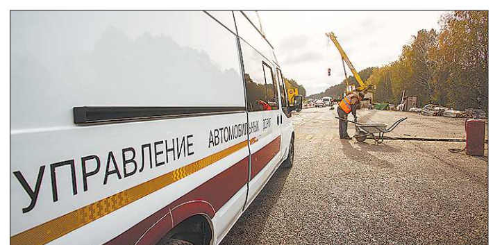
В 2018 году продолжится ремонт моста над железной дорогой у станции «Лубокое» на трассе Екатеринбург — Тюмень. С апреля будет перекрыта правая сторона участка
