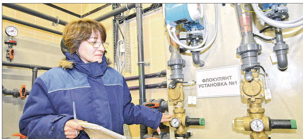
Реагентное хозяйство действует в автоматическом режиме, но сотрудники цеха проверяют работу установок каждый час
