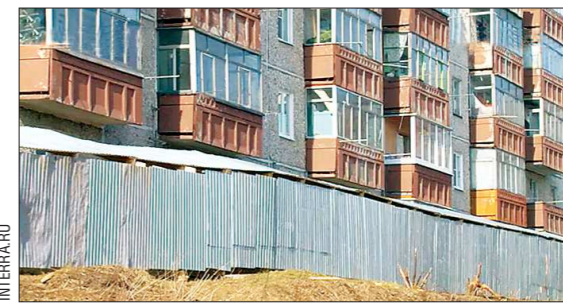
Трёхметровый забор стройки «защитает» не столько от шума и грязи, сколько от света
