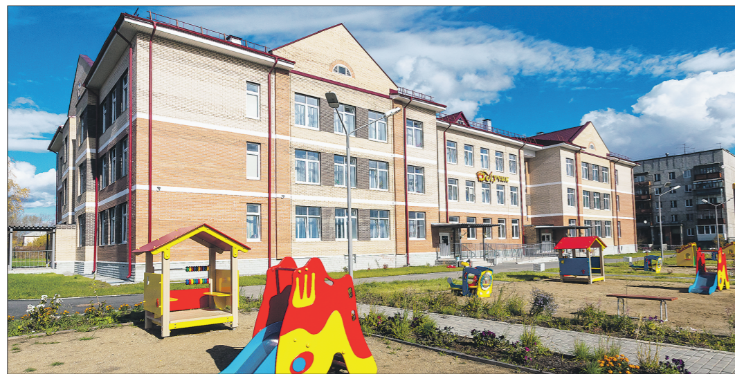
Строительство продолжалось с июля 2013 по декабрь 2014 года
