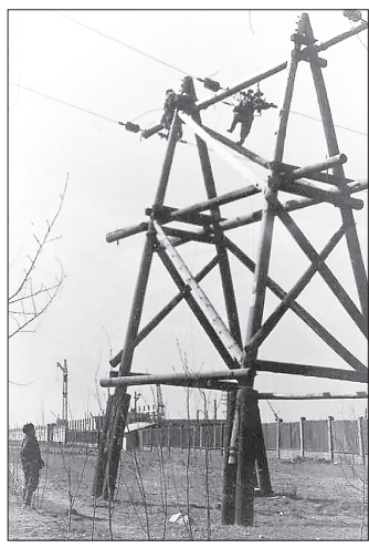
Монтаж линии электропередачи в Пригородном районе. 1943 год. Фото из архива МРСК Урала
