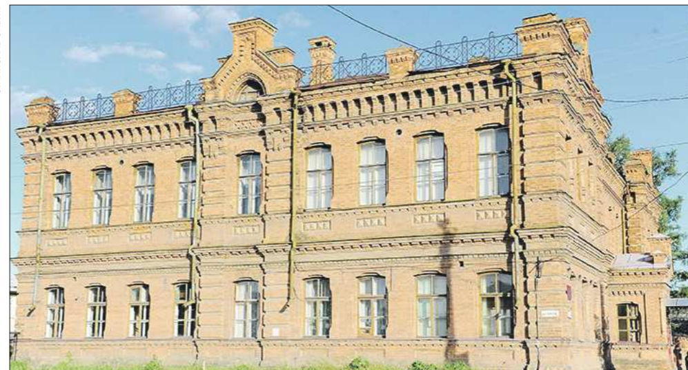
Здание Ирбитского городского училища (ныне — школа №1) было заложено ещё летом 1893 года. Это — один из немногих архитектурных шедевров, за состояние которого городу не стыдно
