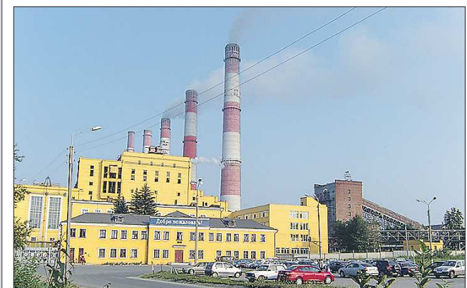
Проектная мощность нового энергоблока Верхнетагильской ГРЭС должна быть не менее 424 МВт
