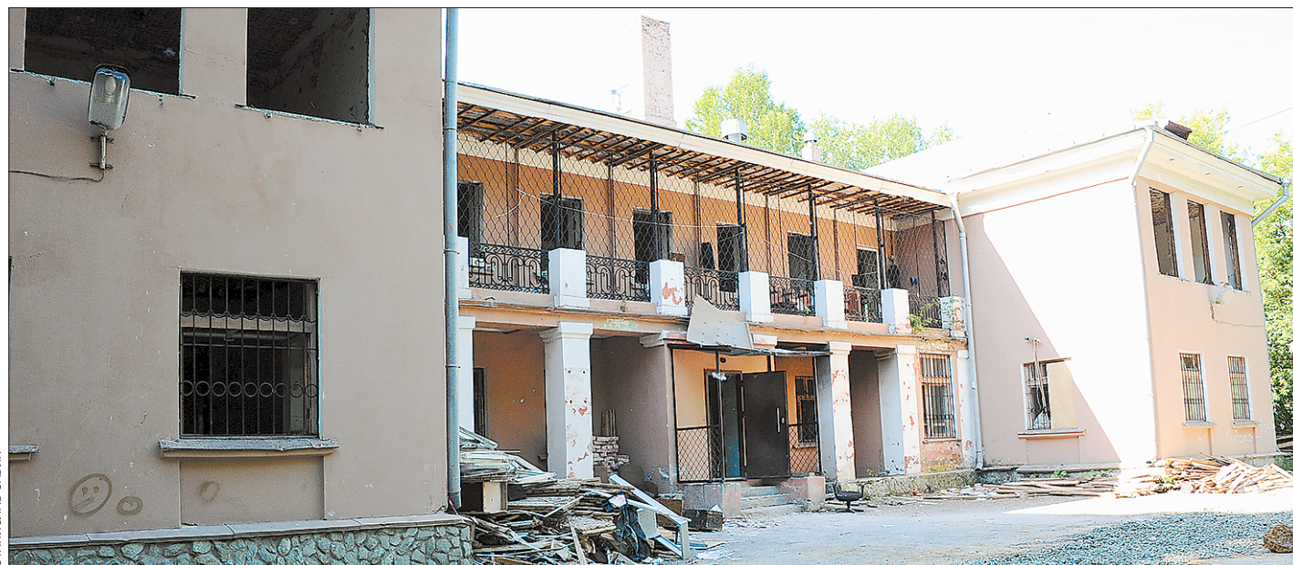
Следственный отдел по Чкаловскому району уже переехал из этого здания по ул. 8 Марта, 129а, детишек садик примет сразу после реконструкции
