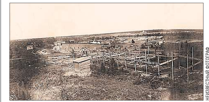
1913 год. Первые дни строительства
