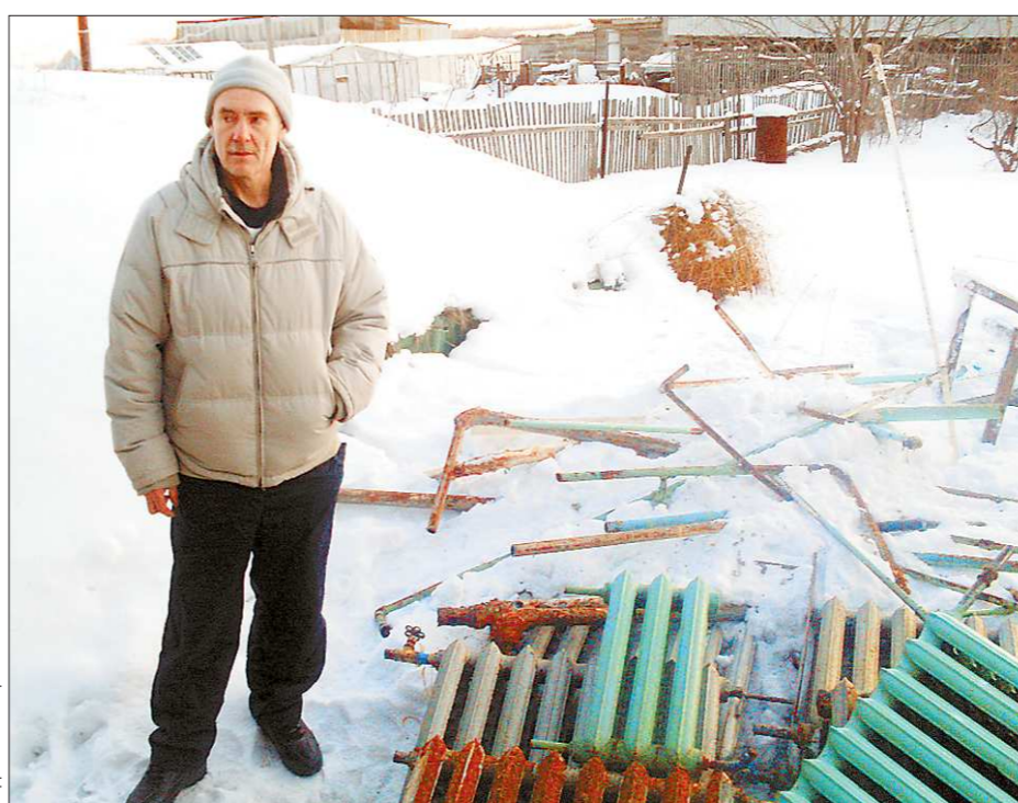
Владимир Шестернев уехал на работу, вернулся — а батареи лопнули. И... была избушка лубяная, стала ледяная
