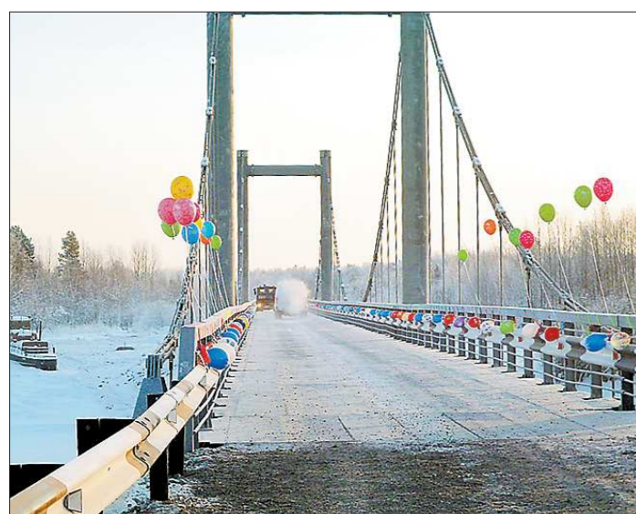
Вопрос о создании моста встал ещё в начале восьмидесятых годов, когда была построена автомобильная дорога Гари - Сосьва. Однако стройка тогда была признана нецелесообразной
