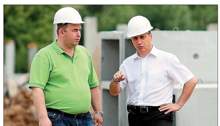
Представитель подрядчика Андрей Механюшин и Леонид Рапопорт обсуждают перспективы ввода в строй манежа
